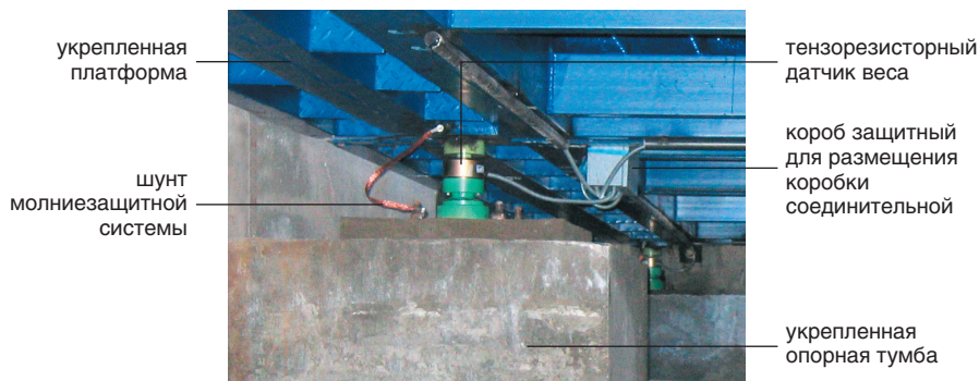
Рис. 3. Вид на тензорезисторный датчик веса из весовой ямы после модернизации. Рычажная система удалена. Опорную тумбу, на которой до модернизации стояла одна из опор рычажной системы, обновили, укрепили, увеличили ее высоту, и на закладную плиту на верхнем торце опорной тумбы поставили тензорезисторный датчик веса с узлом встройки. Слева от датчика виден медный шунт молниезащитной системы.
